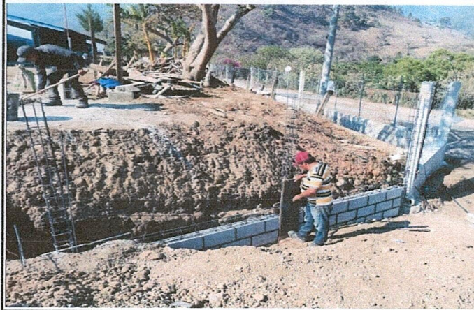
Foto 3: Mejoramiento de reparación de muro perimetral.
